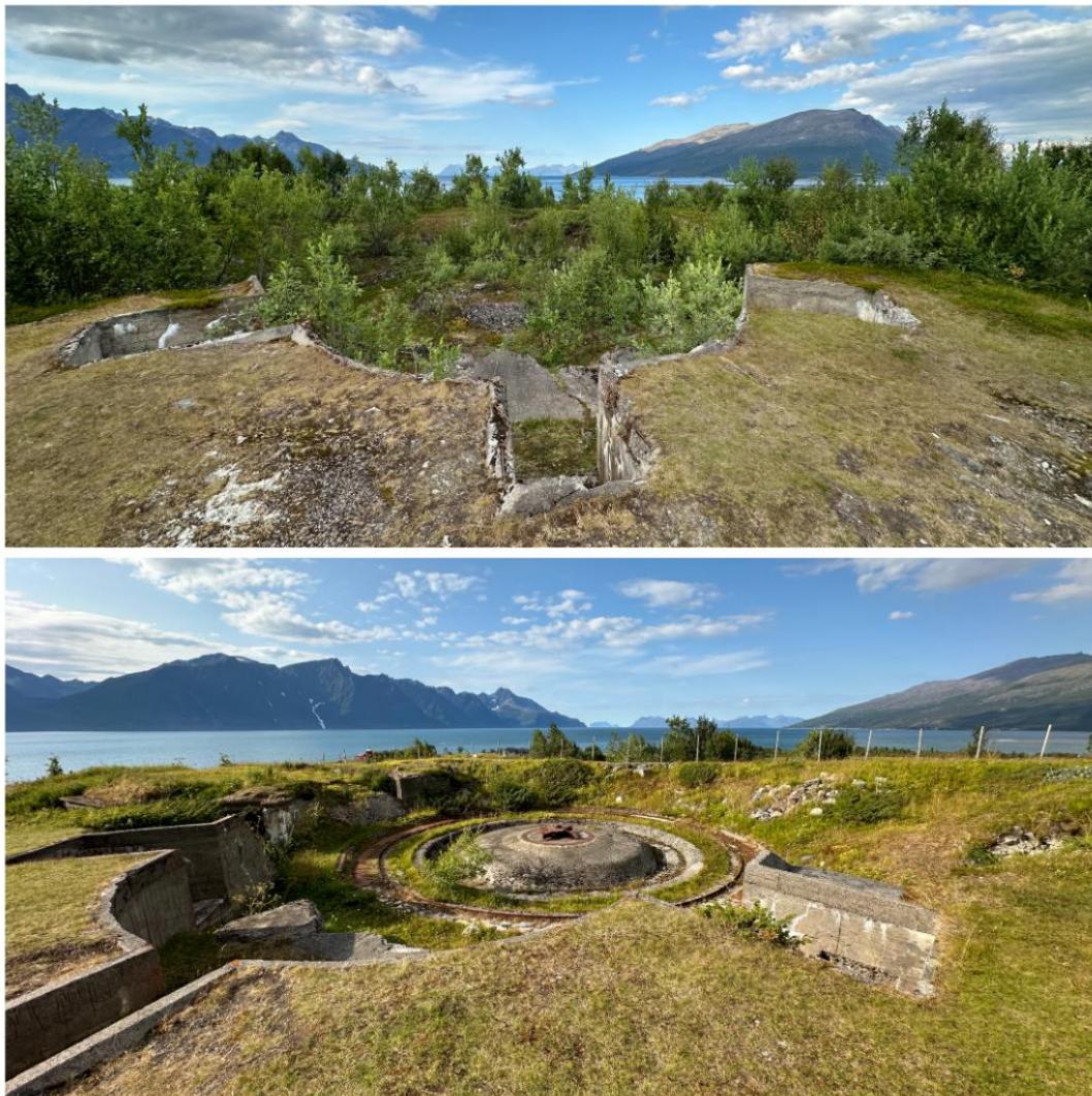
Figur 4: Viser to av artilleribunkersene. Foto: Mona Nilsen
