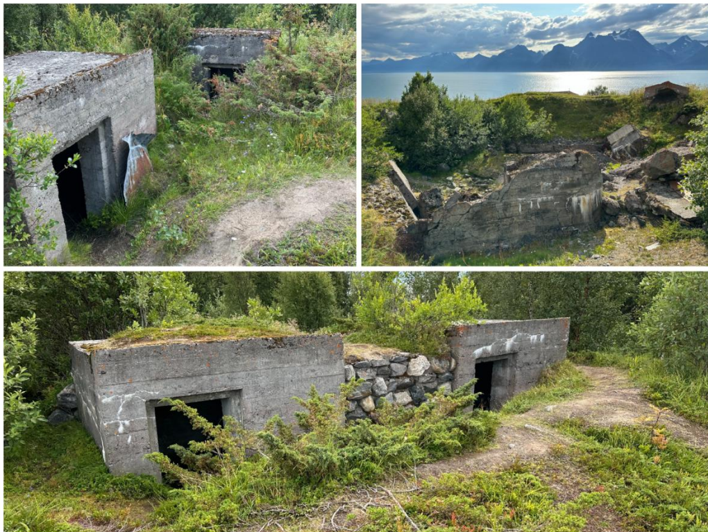
Figur 7: Noen av bunkersene på Spåkenes. Foto: Mona Nilsen
